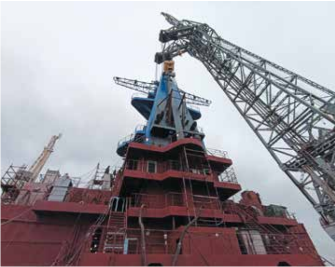
Установка мачты на атомном ледоколе «Чукотка». 2025 год
