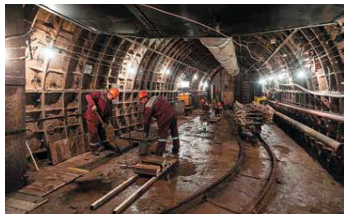
Строительство станции «Достоевская»
