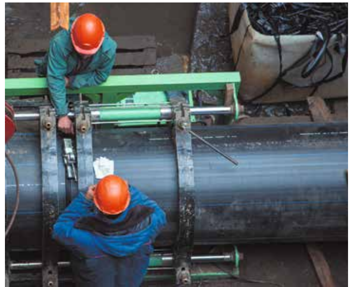
Реконструкция сетей водоснабжения
